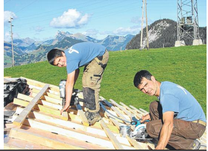
Joël Mottier et son fils Isaac sur un nouveau rural en construction à 1400 mètres d'altitude, près de La Lécherette.
